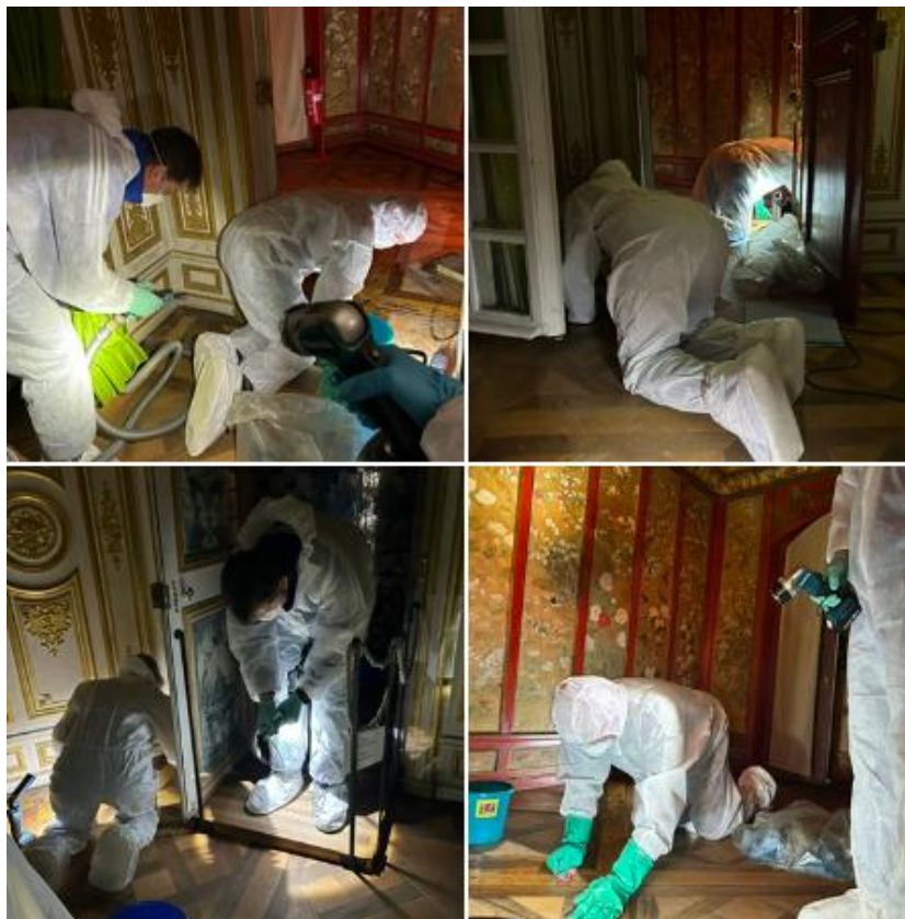
正式使用溶劑清潔發霉地方
